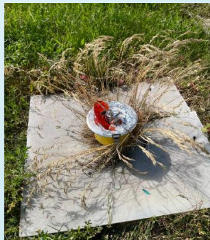
Poškozené pravé koncové světlo příčky na RWY 24
