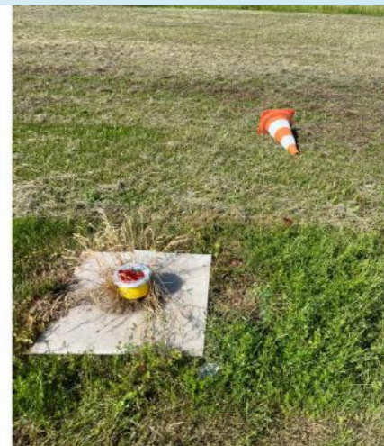
Poškozené pravé koncové světlo příčky na RWY 24
